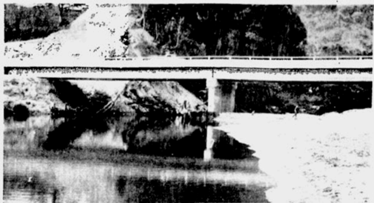
El puente de Mendiaca, uno de los varios que se encuentran a lo largo de la "Transversal del Caribe", cuyo primer tramo entre Riohacha y Paraguaná será inaugurado hoy por el presidente.
