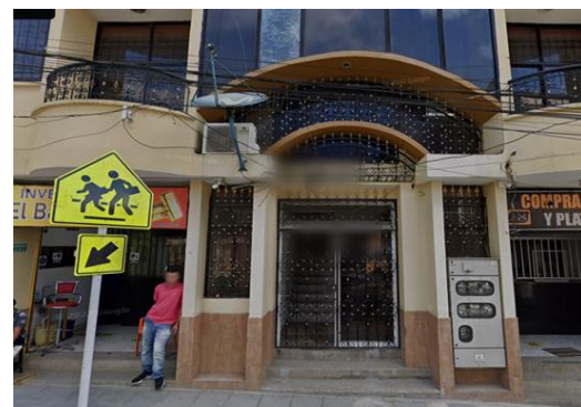
FIGURA 2 FOTOGRAFÍA FACHADA Fuente: Propia
