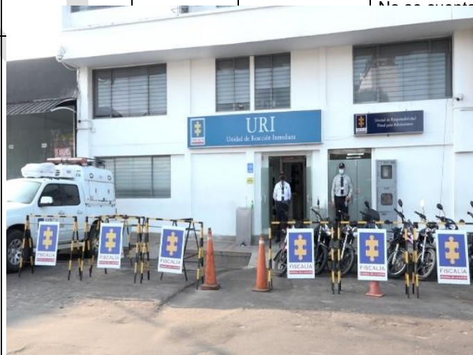
FIGURA 2 FOTOGRAFÍA FACHADA Fuente: https://www.google.com/ .
