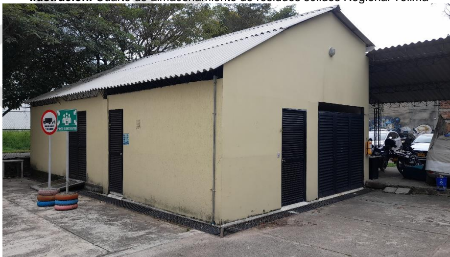
Ilustración. Cuarto de almacenamiento de residuos sólidos Regional Tolima
