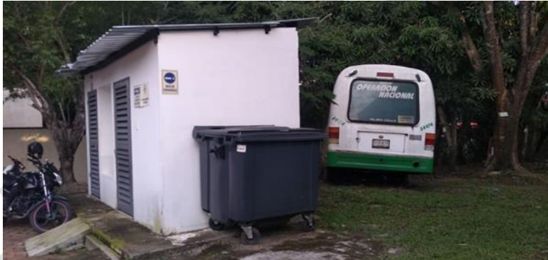
Ilustración 29. Cuarto de Almacenamiento de Residuos Sólidos Centro Zonal Lérica
