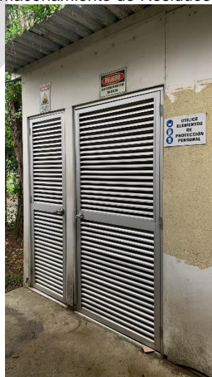
Ilustración 19. Cuarto de Almacenamiento de Residuos Sólidos Centro Zonal Ibagué
