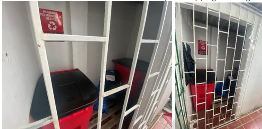
Ilustración 10 . Cuarto de almacenamiento de residuos especiales y peligrosos Regional Atlántico
