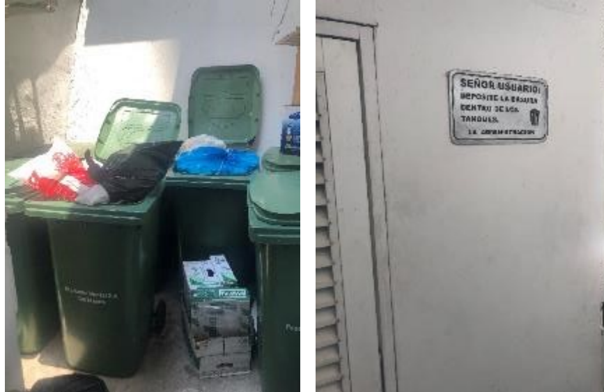
Ilustración 10. Cuarto de almacenamiento de residuos ordinarios
