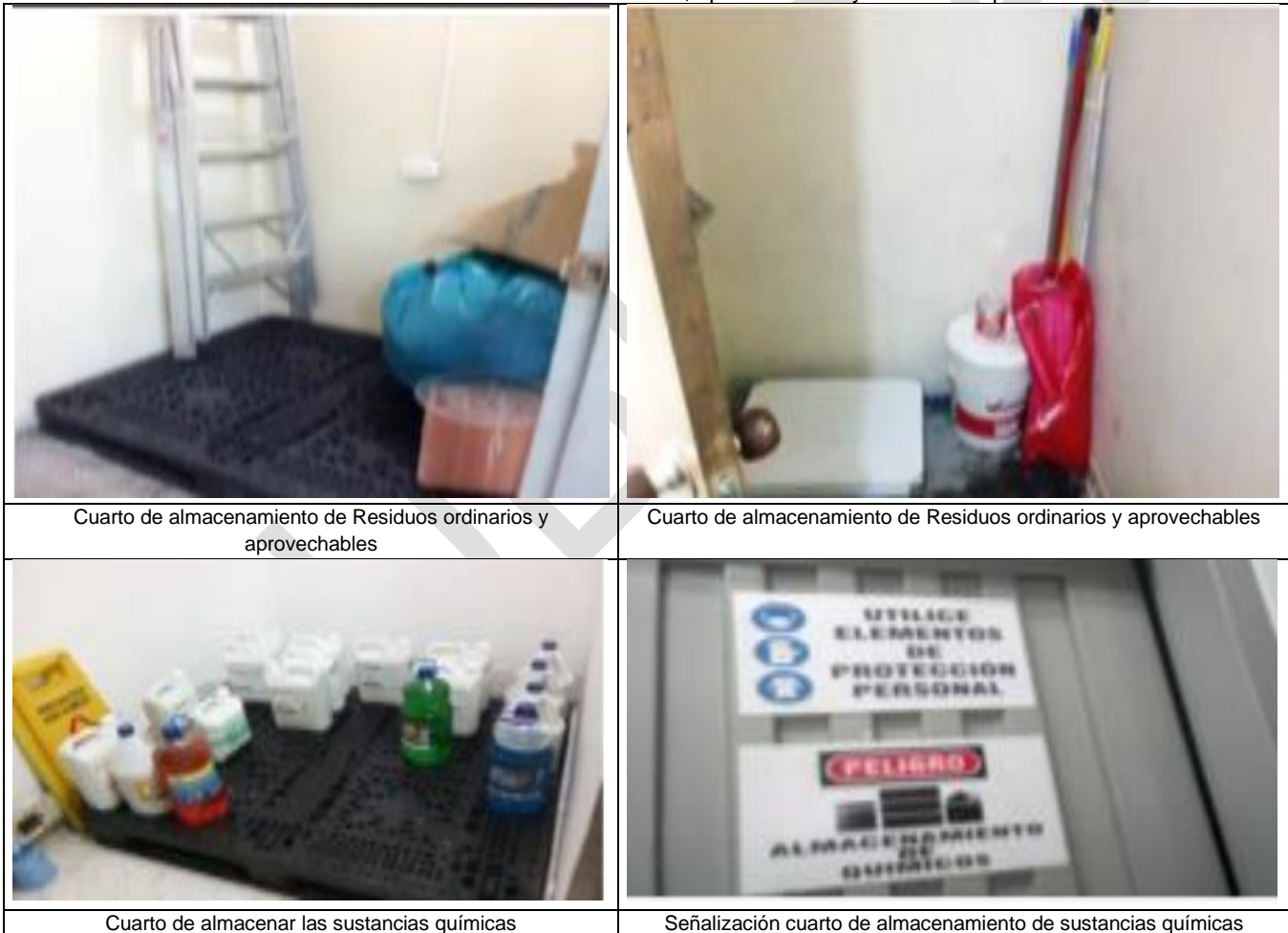
Ilustración 18. Cuarto de almacenamiento de residuos ordinarios, aprovechables y sustancias químicas Centro Zonal Norte
