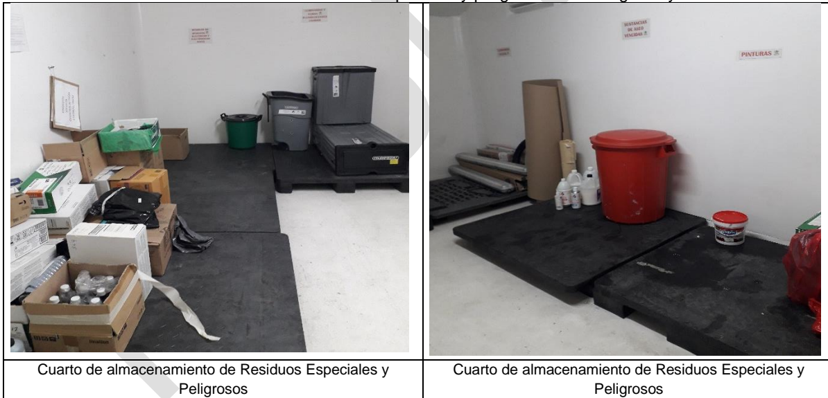
Ilustración 11. Cuarto de almacenamiento de residuos especiales y peligrosos Sede Regional y Centro Zonal Manizales 2
