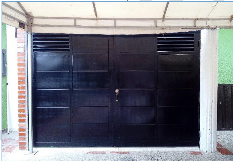
Ilustración 9: Cuarto de Almacenamiento Temporal de Residuos Sede Centro zonal Tame.
