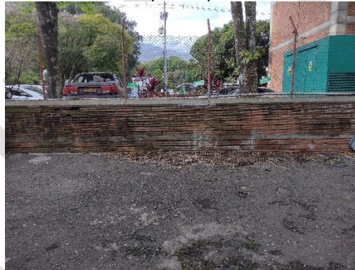
Ilustración 23. Área de acopio temporal de RCD Sede Regional
