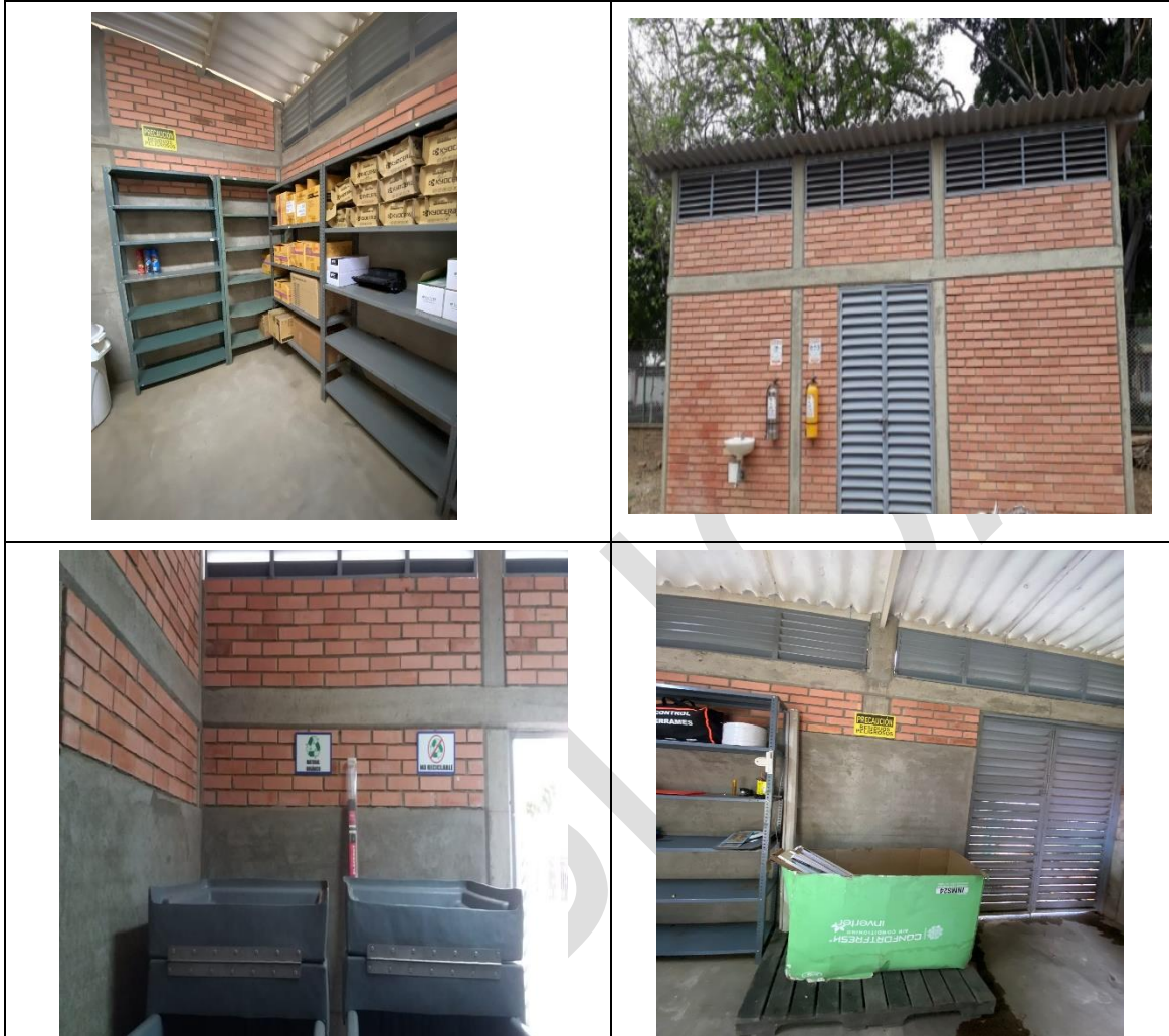
Ilustración 5. Cuarto de almacenamiento temporal de residuos Regional Norte de Santander
