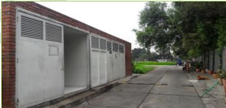
Ilustración 3. Exterior del cuarto de almacenamiento temporal de residuos
