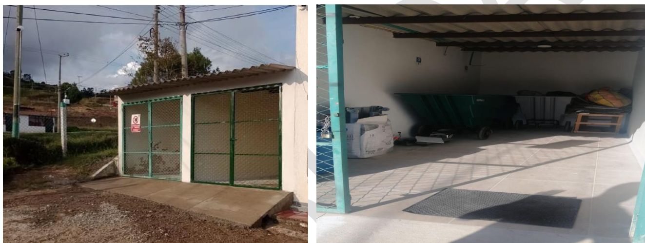
Ilustración 15. Cuarto de almacenamiento de residuos ordinarios Regional Boyacá
