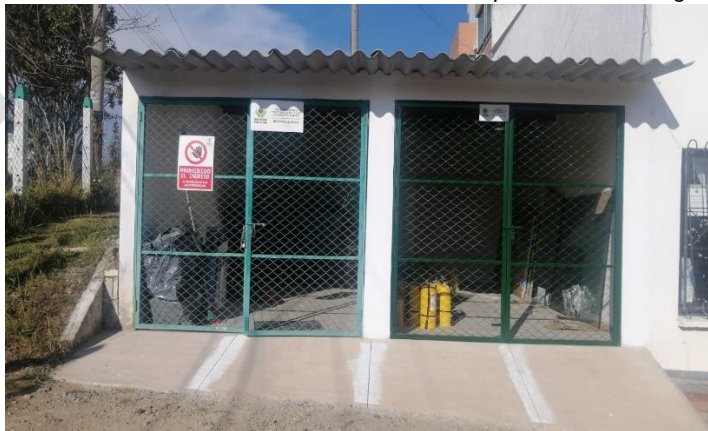
Ilustración 29. Cuarto de almacenamiento de residuos aprovechables Regional Boyacá
