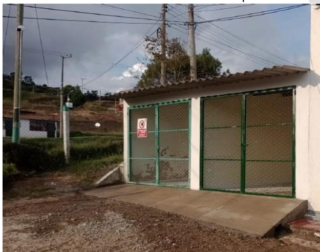
Ilustración 28. Cuarto de almacenamiento de residuos no aprovechables Regional Boyacá
