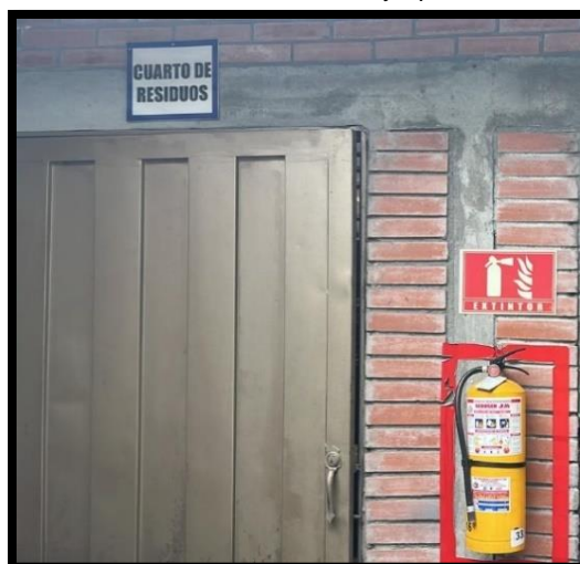
Ilustración 7. Cuarto de almacenamiento de residuos ordinarios y aprovechables regional Huila y centro zonal Neiva
