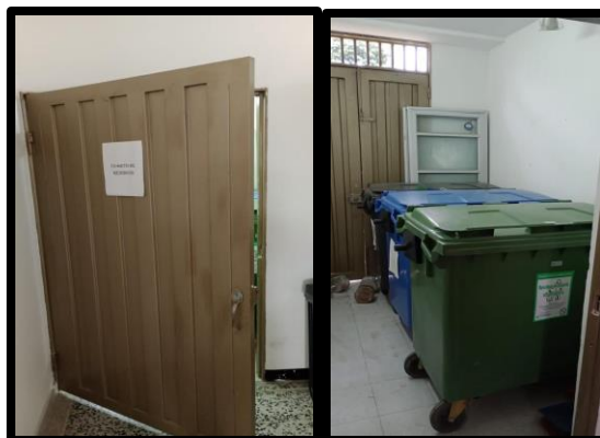
Fotografía 1- 5 Cuarto de almacenamiento de residuos especiales y peligrosos centro zonal Pitalito
