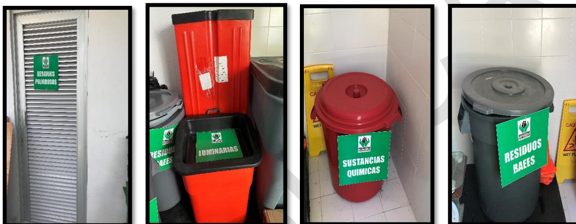
Ilustración 5. Cuarto de almacenamiento de residuos especiales y peligrosos Regional San Andrés
