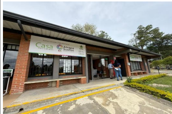
FIGURA 2 FOTOGRAFÍA FACHADA Fuente: regional cauca
