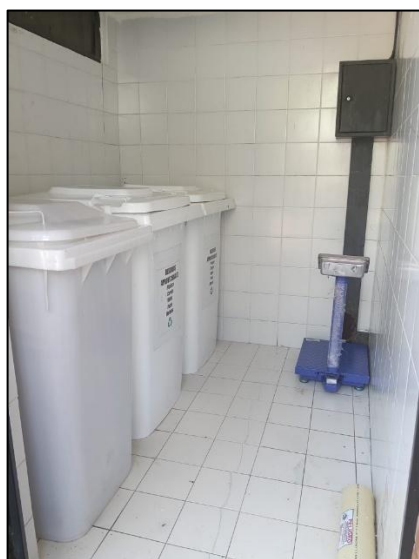
Registro fotográfico cuarto de almacenamiento residuos especiales y peligrosos:
