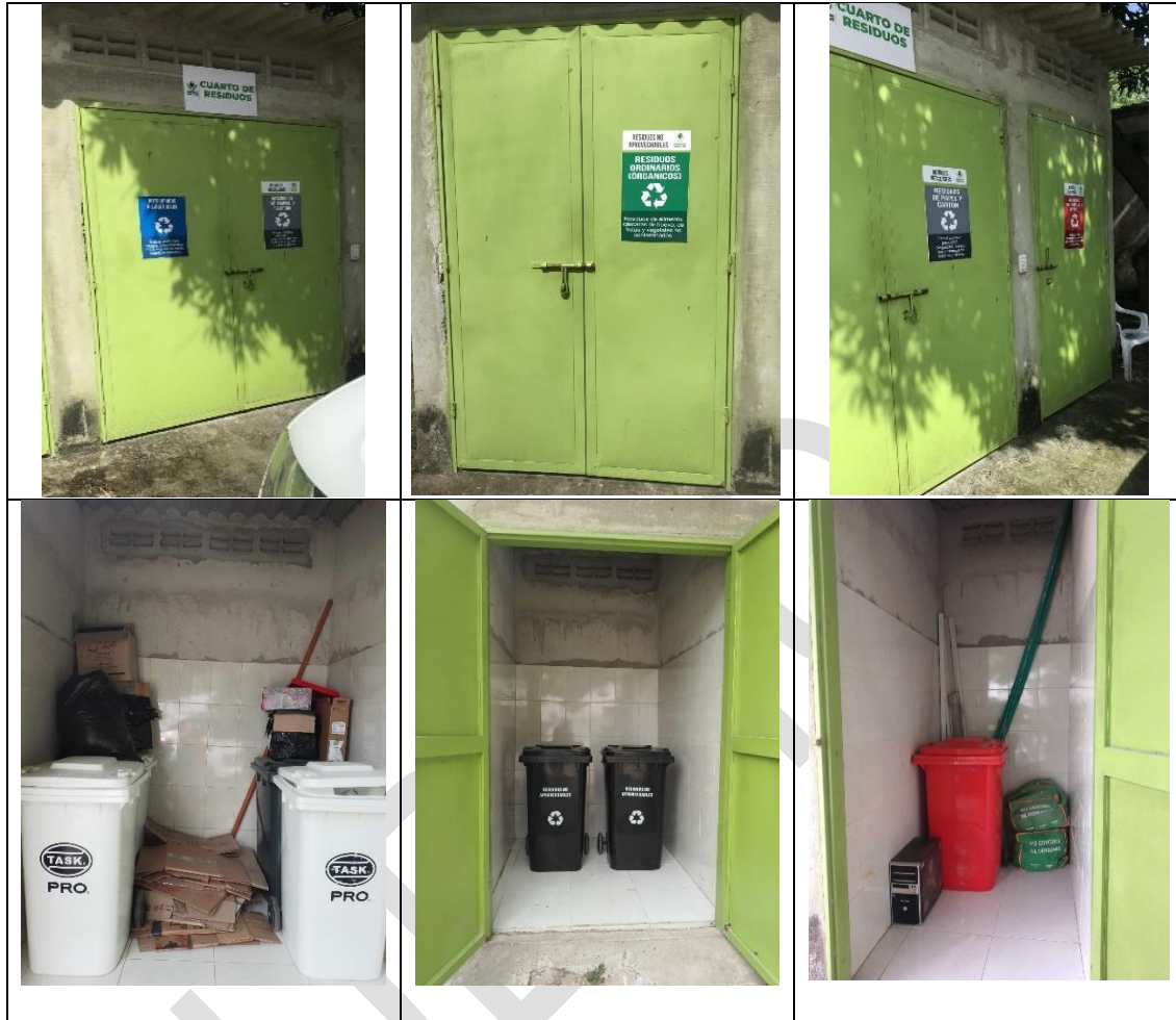
Ilustración 11. Cuarto de almacenamiento de residuos CZ. Suroriente.
