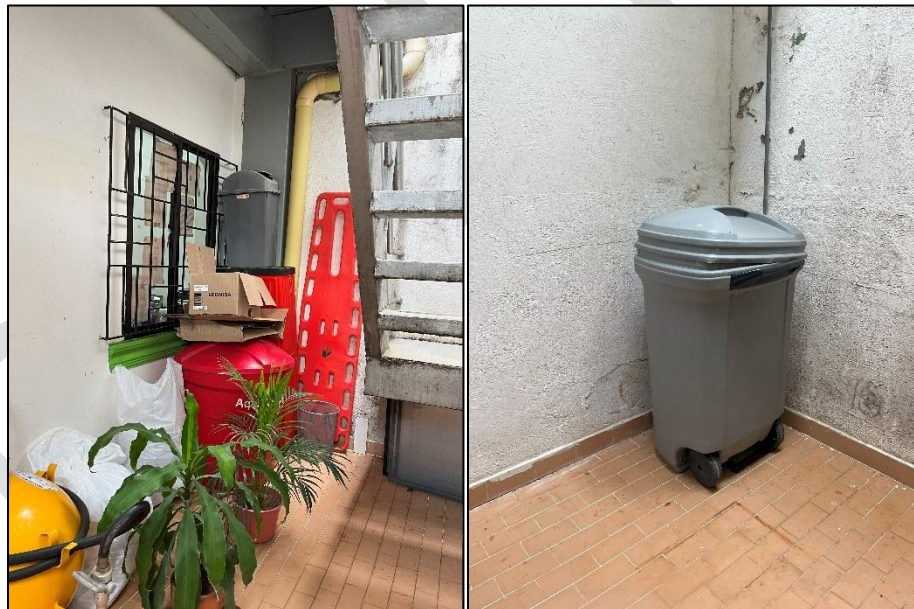
Ilustración 15. Contenedores de almacenamiento de residuos Montelibano
