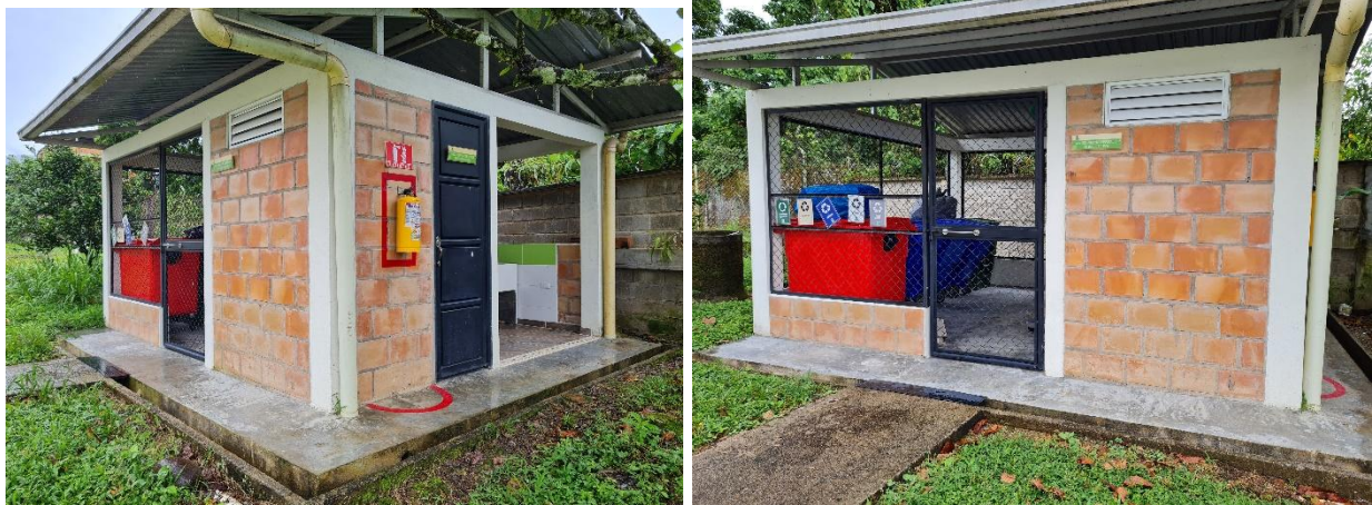
Ilustración 11. Cuarto de almacenamiento de residuos aprovechables y peligroso Regional Putumayo
