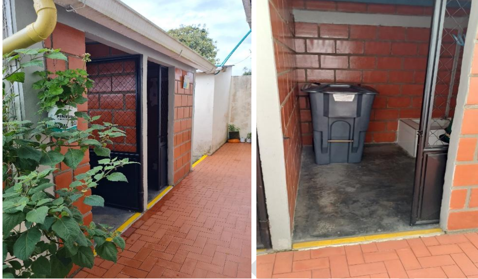
Ilustración 15. Cuarto de almacenamiento de residuos aprovechables Centro Zonal Sibundoy
