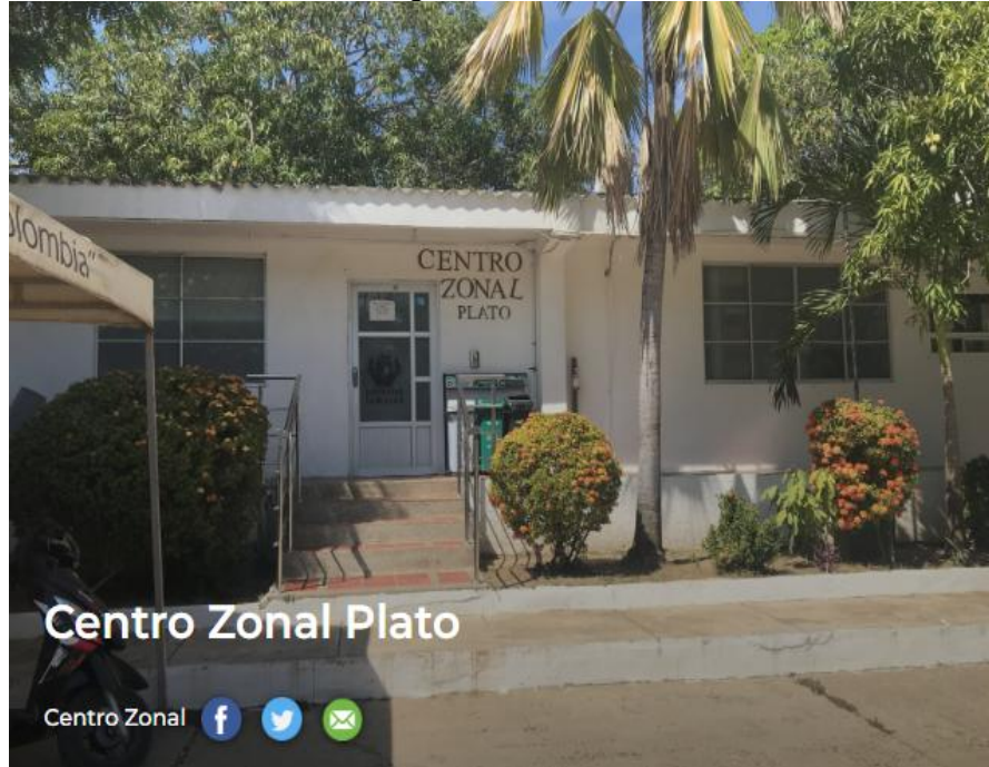
Ilustración 7. Fotografía fachada Centro Zonal Plato.
