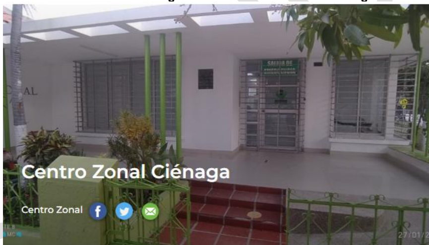
Ilustración 4. Fotografía fachada Centro Zonal Ciénaga.
