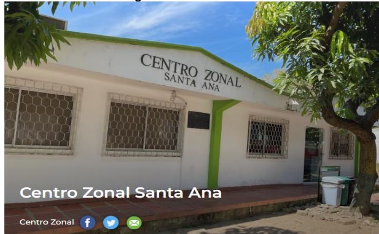
Ilustración 8. Fotografía fachada Centro Zonal Santa Ana .
