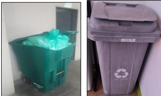
Ilustración 19. Contenedores almacenamiento de residuos ordinarios y Aprovechables Cz. Soacha Terreros
