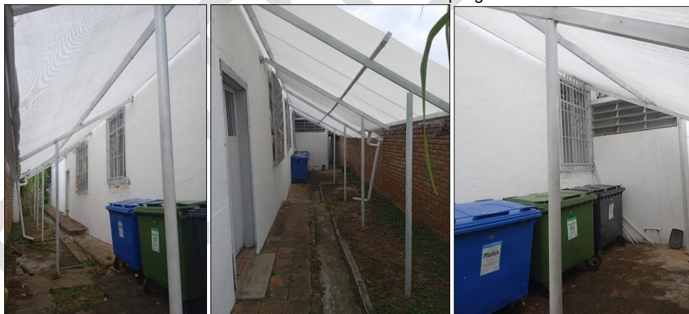
Ilustración 13 Cuarto de almacenamiento de residuos no peligrosos Centro Zonal Garzón
