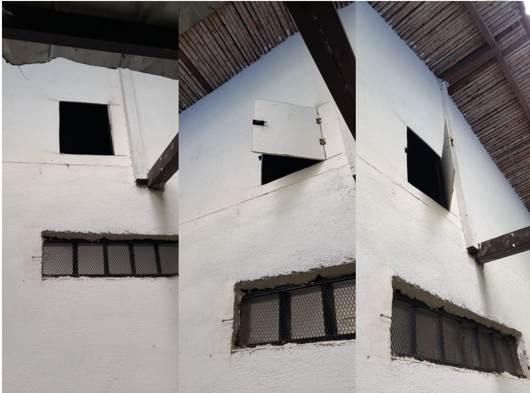
Puerta Cielo Falso
