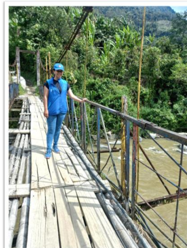
Puente de acceso a la vereda antes
