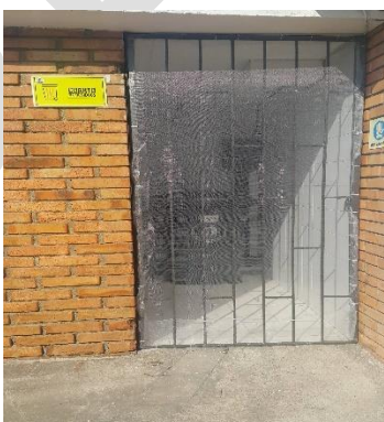
Imagen 2 Cuarto de Almacenamiento de Temporal de Residuos Sede Regional Casanare
