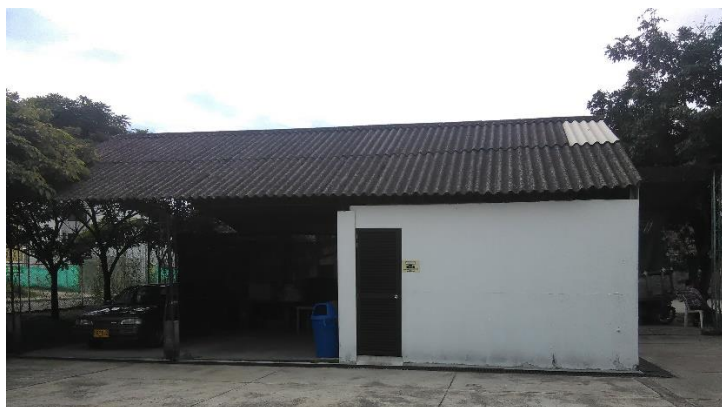
Imagen 2: Cuarto de Almacenamiento de Temporal de Residuos Sede Regional Tolima
