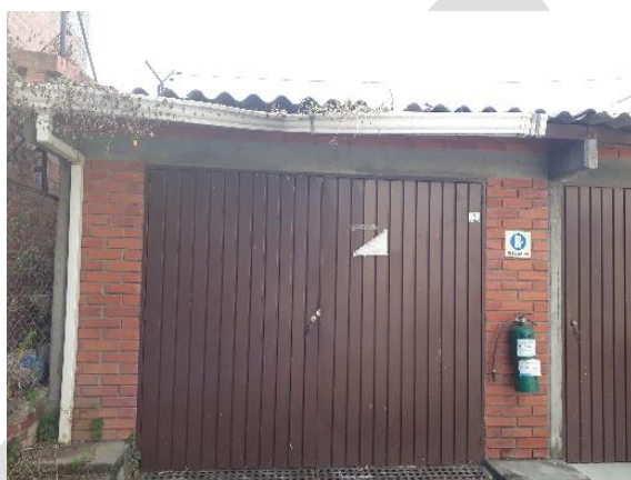
Fotografía 3. Entrada a cuarto de almacenamiento de residuos Ordinarios.
