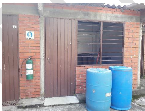
Fotografía 1. Entrada al cuarto de almacenamiento de residuos Aprovechables y Peligrosos.
