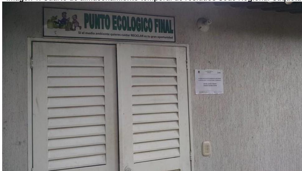
Imagen 1. Cuarto de almacenamiento temporal de residuos Sede Regional Caquetá
