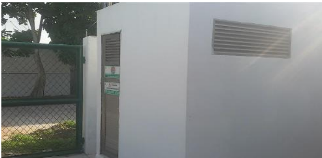
Imagen 2 Exterior del cuarto de almacenamiento temporal de residuos
