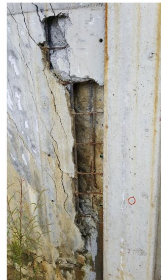
Vista de la parte posterior del proyecto, se observa muro lateral que ha fallado por efecto de la carga impuesta al mismo por efecto del deslizamiento.
