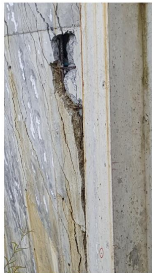
Vista de la parte posterior del proyecto, se observa muro lateral que ha fallado por efecto de la carga impuesta al mismo por efecto del deslizamiento.
