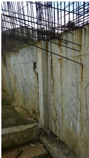
Vista de la parte posterior del proyecto, se observa muro lateral que ha fallado por efecto de la carga impuesta al mismo por efecto del deslizamiento.
